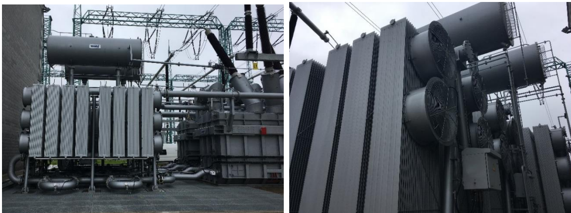
obr. 6-8 Chladicí systém PST
