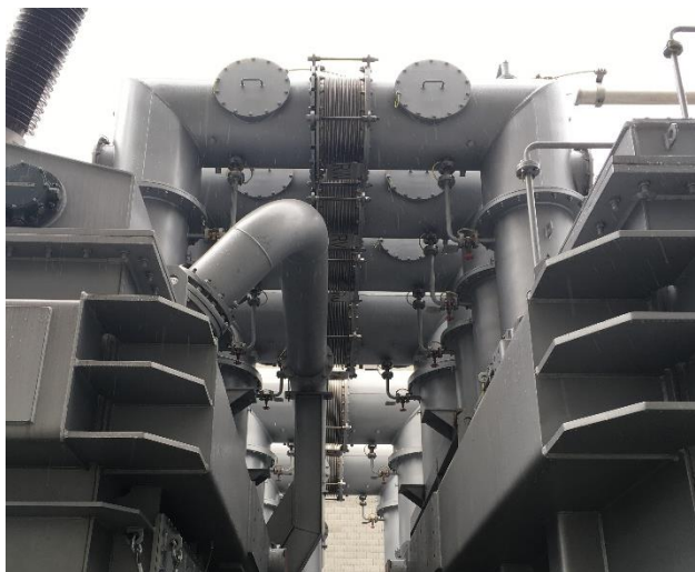
obr. 6-9 Propojení sériové a budicí jednotky
